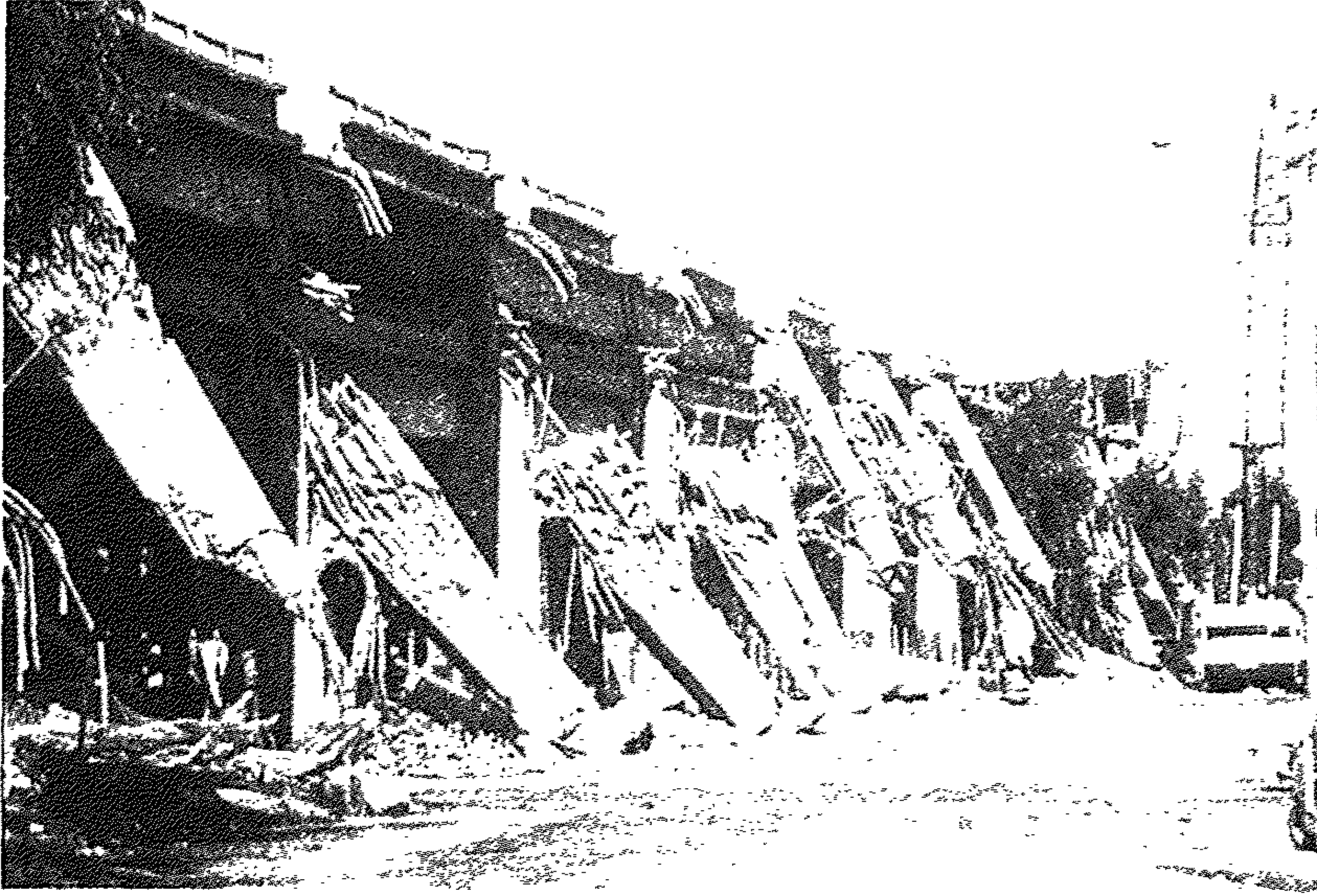
الشكل (٢٧-٤) قطاع من الطريق السريع الموصل بين الولايات ندى المستويين رقم ٨٨٠ عند أوكلاند استكمل بناؤه في عام ١٩٥٧؛ وانهار في زلزال ١٩٨٩ وسقط من سطح الطريق العلوى ١,٢٥ ميلا فوق الطريق السريع ساحقا الكثير من السيارات والناس.
